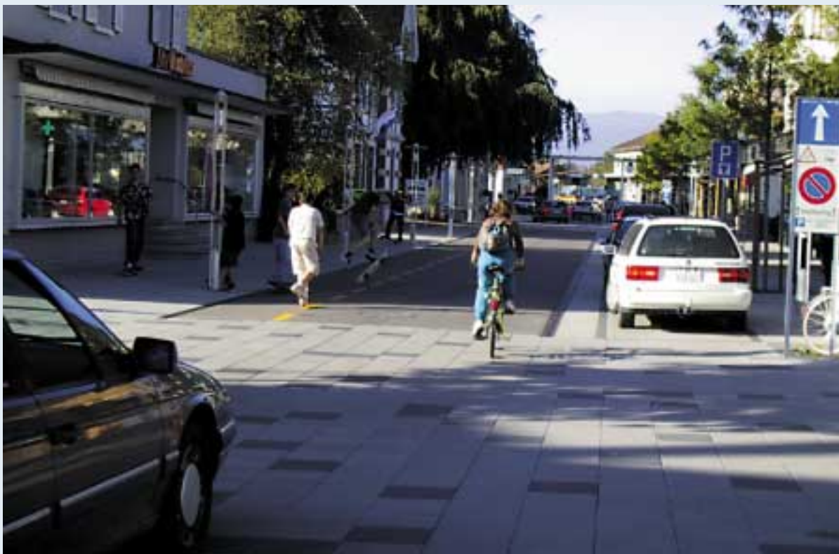
La mixité est obtenue grâce au changement de revêtement qui relie le trottoir à la chaussée.
