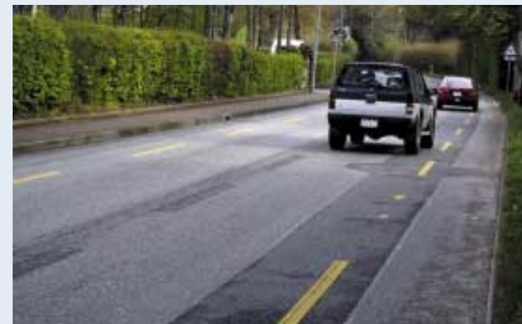
Double bande polyvalente sur une chaussée de 7 mètres de large. A noter que la bande médiane a été effacée.
