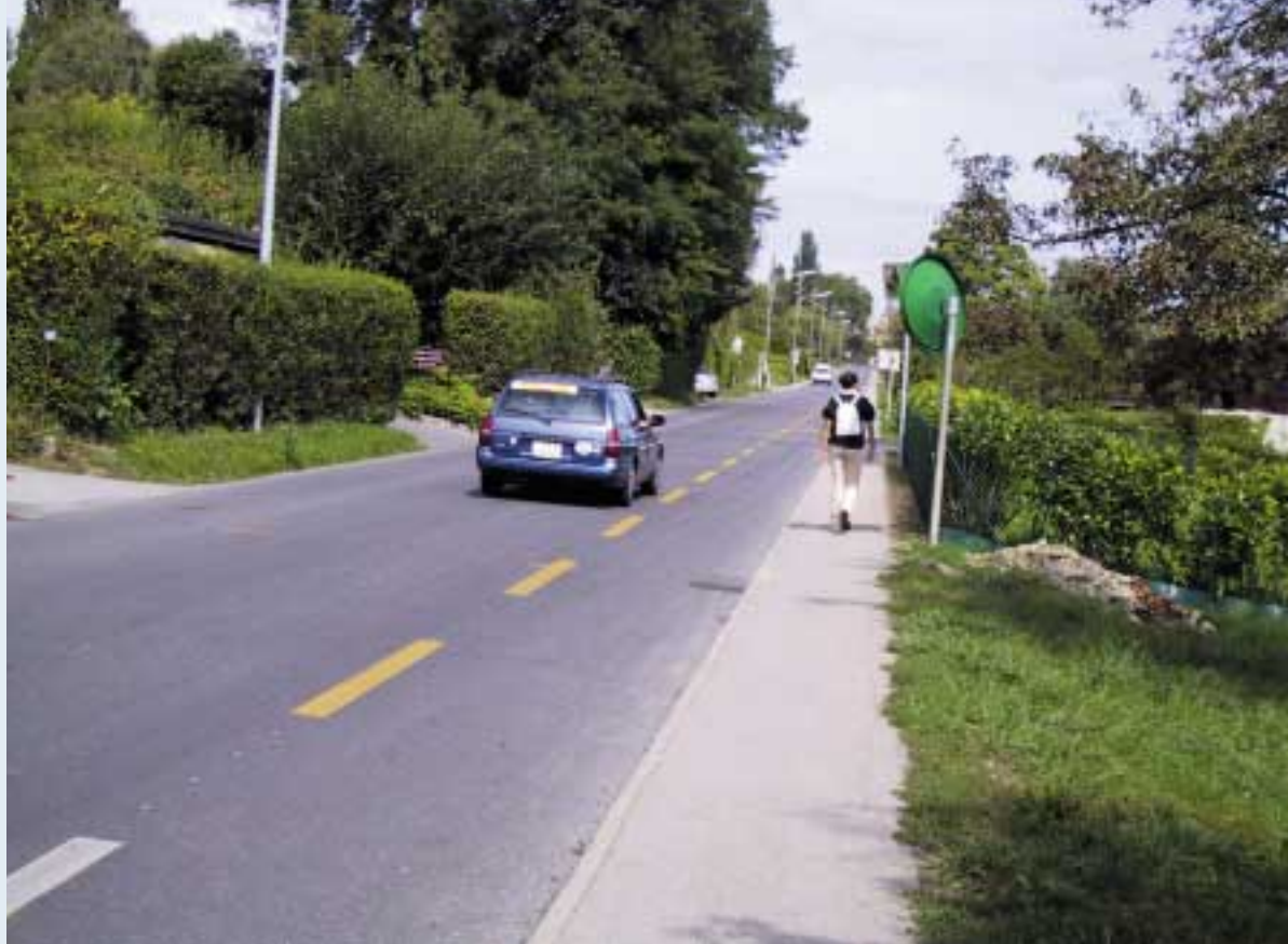
Largeur de la chaussée, 6 mètres seulement dont 1,5 mètre pour la bande cycliste polyvalente. Celle-ci est respectée quand bien même aucun cycliste n'y circule. L'automobiliste pourra l'utiliser pour croiser.
